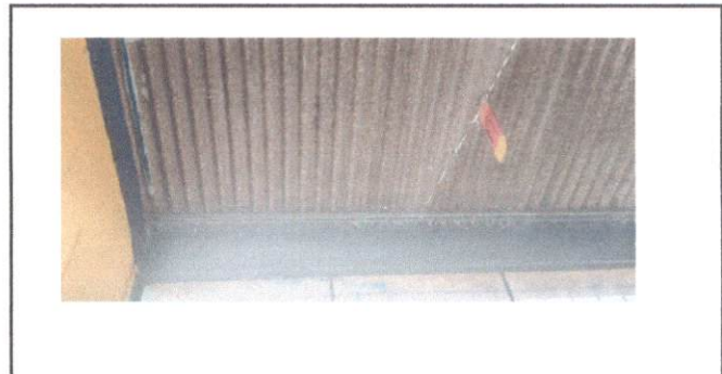
Foto 6: sustitución de capote de lamina, Sustitución de lamina troquelada por lamina aluzinc calibre 26 y sustitucin de elementos de fijación.
