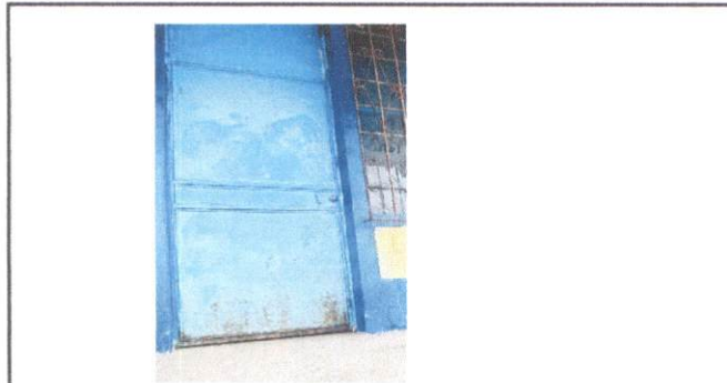
Foto 3: Sustitución de puertas de metal por puertas de metal por metal
