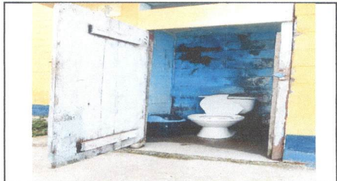
Foto 2: Sustitución de puertas en servicio sanitario
