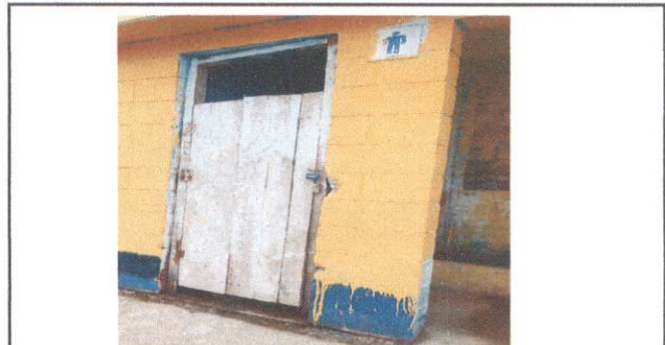
Foto 4: Sustitución de puertas de madera por puertas de metal por metal
