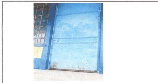
Foto 5: Sustitución de puertas de metal por puertas de metal por metal
